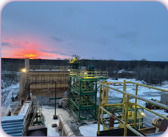
Un beau lever de soleil sur l'installation de St. Canut (Jonathan Jasmin)
