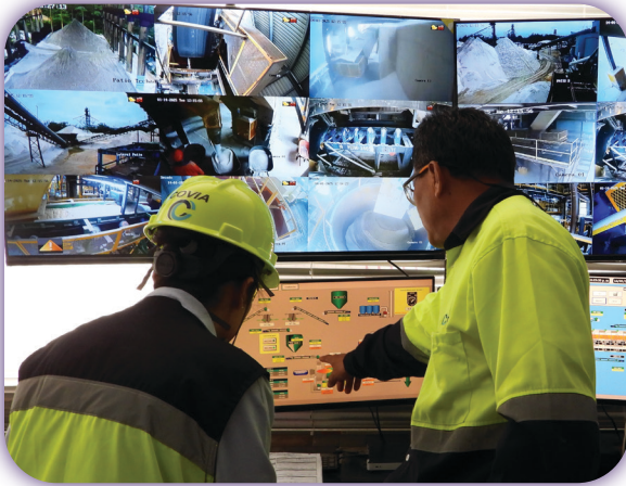
Travailler dans la salle de contrôle du séchage à Jaltipan (Ruben Peña Ramirez)
