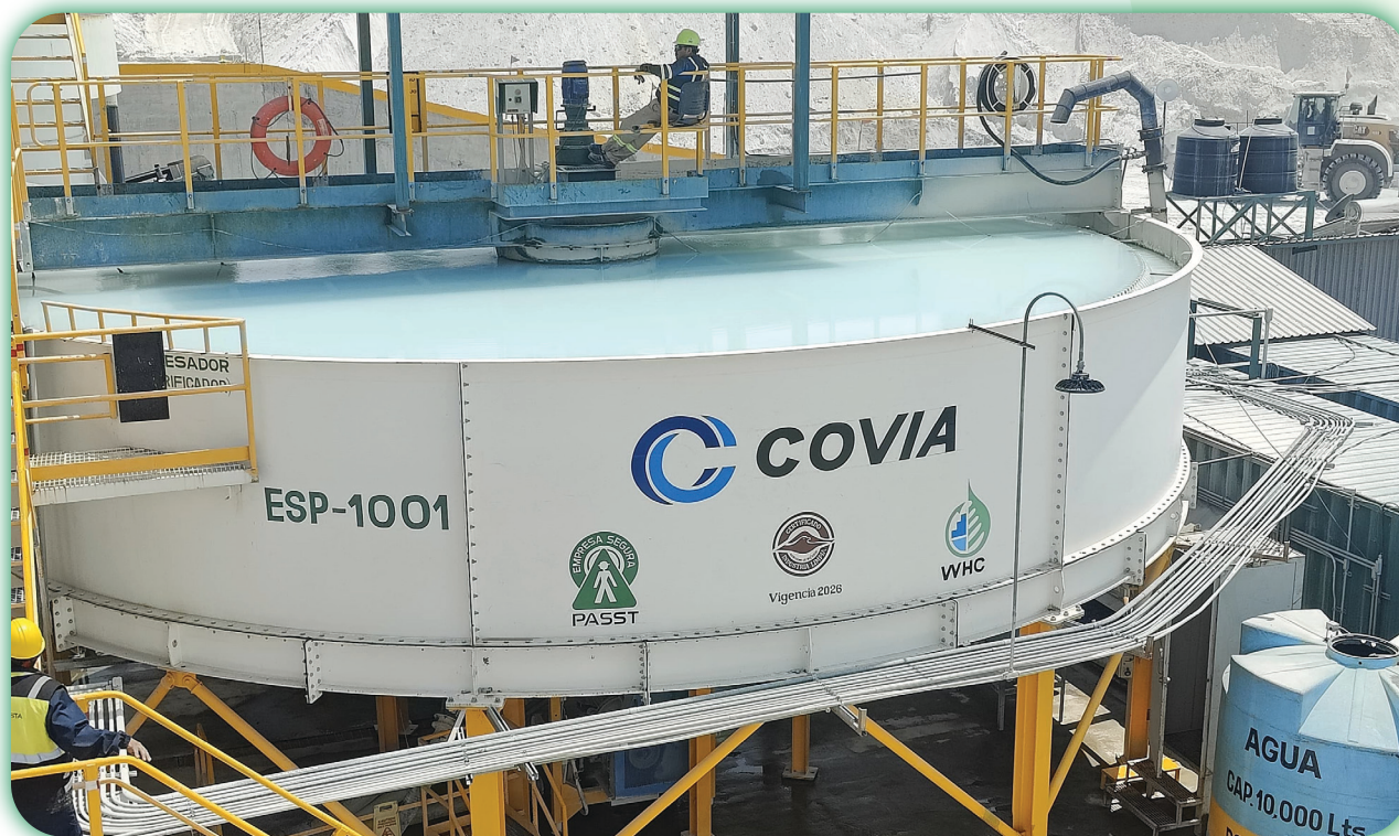
Le réservoir d'eau (Andrea Cabrera)
