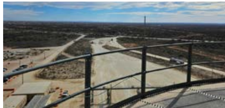
Vue du dessus depuis la grue Soumis par Heather McComas
