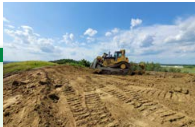
Travail de pré-remise en état à Menomonie Soumis par Jeremy Wagner
